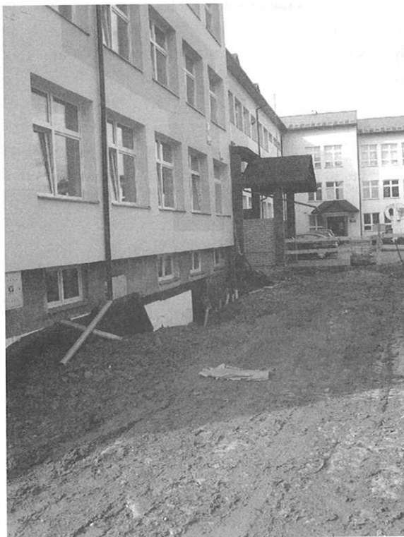
Izolacja fundamentów szkoły we Frysztaku.
