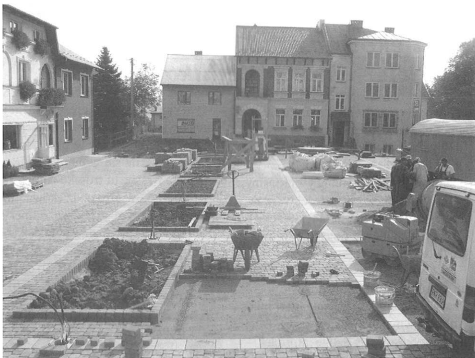
Plac św. Floriana podczas remontu.
