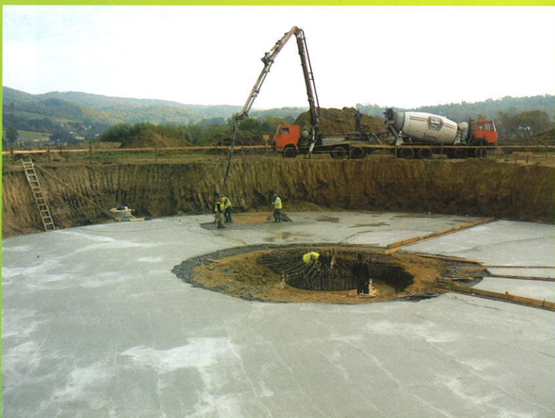
Budowa oczyszczalni ścieków w Pułankach.
